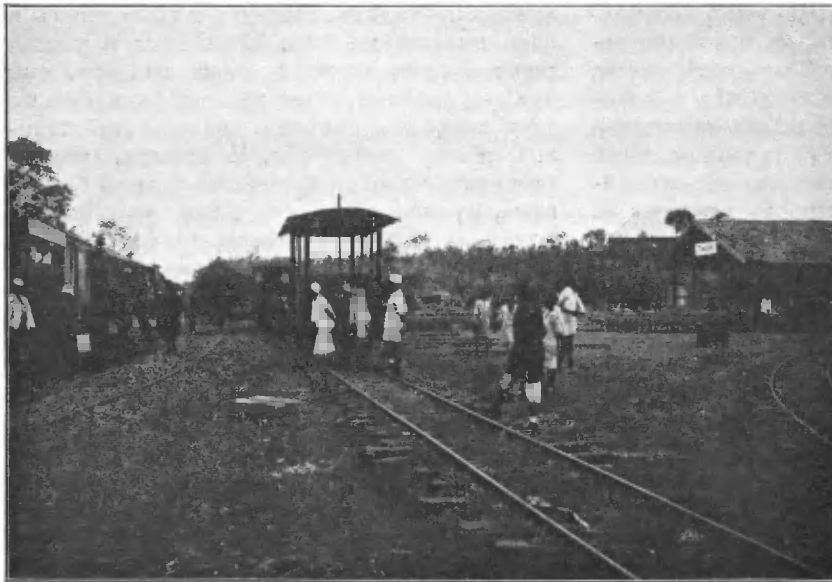
Рис. 3. Станція Тенгени. На-лѣво поѣздъ изъ Танги, на-право зданіе вокзала и вѣтвь на Сиги.
